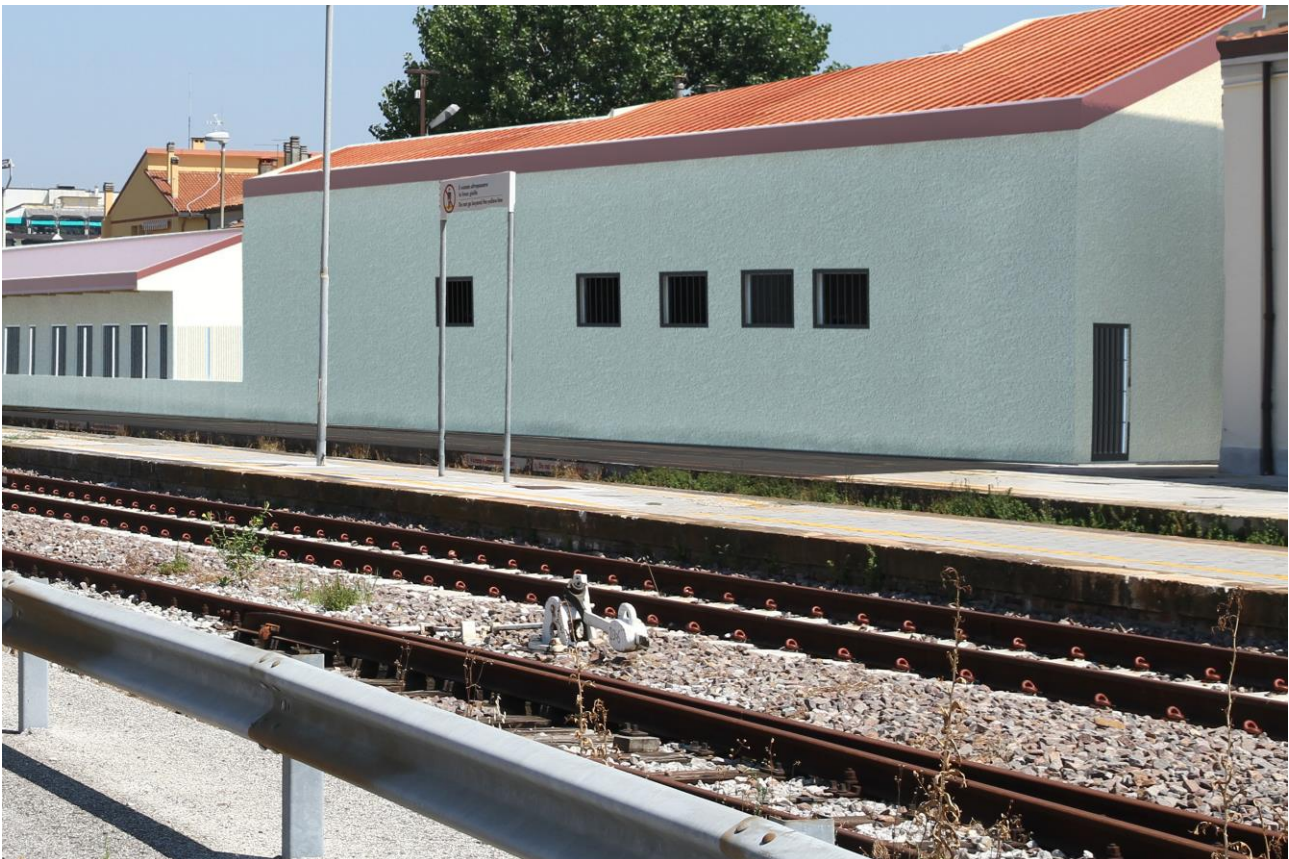
Vianelli ex pescheria, lato ovest, banchina ferroviaria. Stato di Riforma
