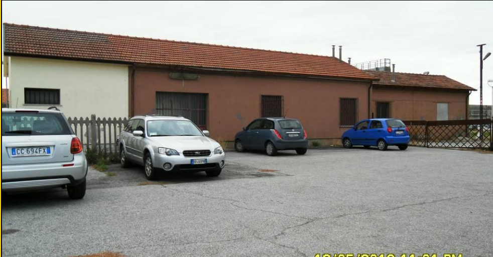
Foto n. 2a – Manufatto oggetto dell'intervento. Vista est da Piazzale della Stazione Ferroviaria.
