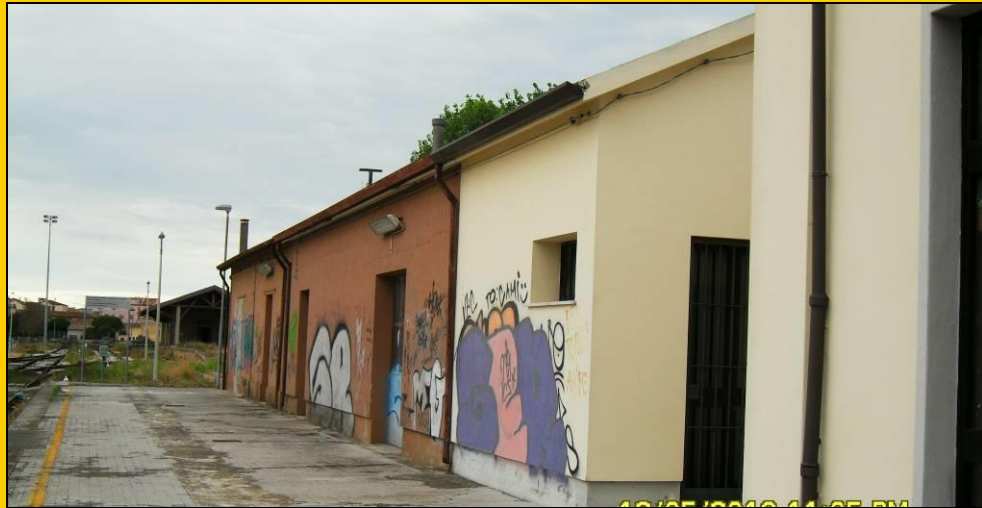
Foto n. 2b – . Manufatto oggetto dell'intervento. Vista ovest dalla banchina di aspetto della Stazione Ferroviaria.
