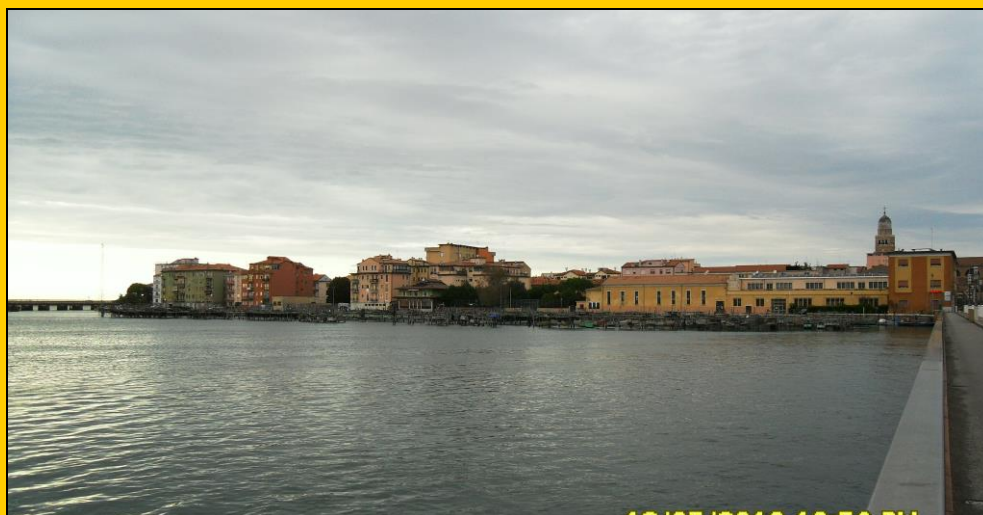
Foto n. 8 – Porzione di laguna compresa tra i due viadotti.
