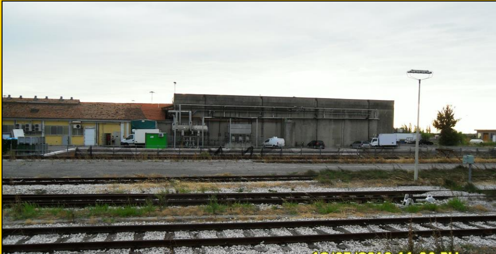
Foto n. 4a – Area artigianale vista dalla Stazione.
