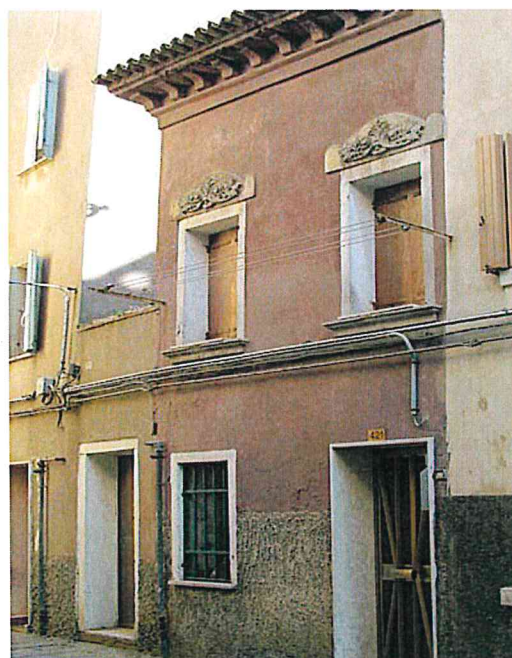
Chioggia - Edificio storico a due piani con elementi di finitura in "pietra artificiale" apposti sulla facciata nei primi del novecento.
