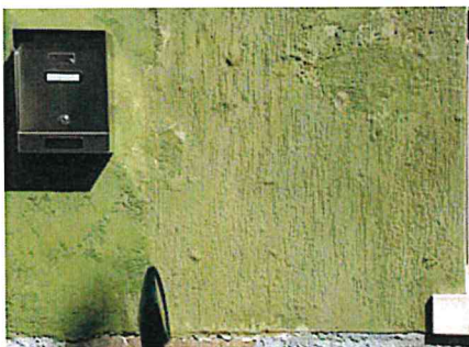
Chioggia e Sottomarina –Tinteggiature di circa 1mm di spessore lavorate in superficie con il frattazzo dentato al fine di ottenere caratteristico effetto "graffiato". Questa finitura è stata utilizzata soprattutto negli anni '80.
