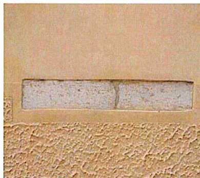
Davanzale di una finestra tamponata lasciato a vista.
