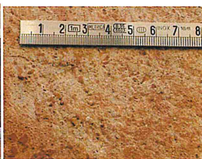
Strato di preparazione realizzato con malta di calce e cocchiopesto.
