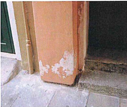
Chioggia – Edificio in Calle Gradara. – Particolare della zona basamentale dove è stato applicato un intonaco deumidificante macroporoso.
