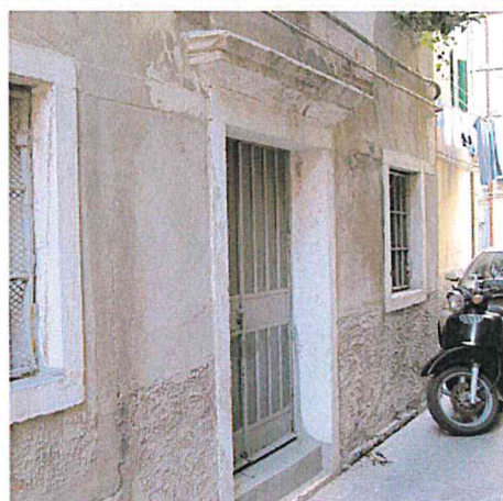
Particolare della porta con le sue aperture laterali, cornici in pietra d'Istria
