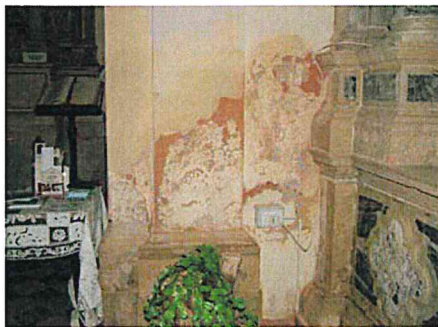
Chioggia – Chiesa di S.Andrea. Particolari della zona basamentale interna corrispondente a quella esterna (segnalata nelle immagini precedenti), dove è stato applicato un intonaco risanante a base cementizia. All'interno, invece, è stato applicato un intonaco da risanamento a base di coccopesto.
