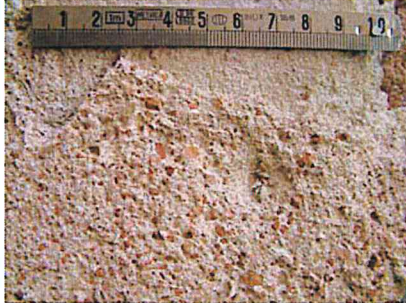
Strato di preparazione realizzato con malta di calce e cocchiopesto.
