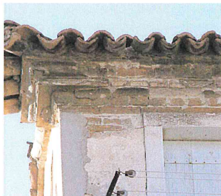
Dettaglio del cornicione in mattoni sagomati, stuccati in marmorino
