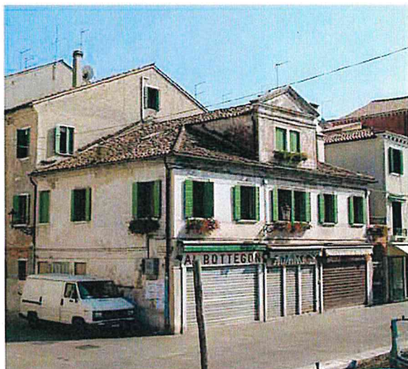
Chioggia - Facciate con intonaci di cocciopesto e finitura a "marmorino"
