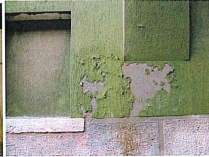
Chioggia e Sottomarina –Tinteggiature di circa 1mm di spessore lavorate in superficie con il frattazzo dentato al fine di ottenere caratteristico effetto "graffiato". Questa finitura è stata utilizzata soprattutto negli anni '80.
