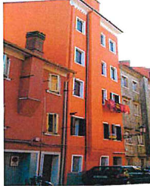
Chioggia e Sottomarina – Recenti intonaci colorati in pasta in varie tonalità di colore.
