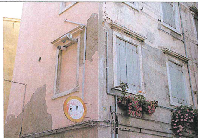
sostituzione di intonaco in cocciopesto nella facciata sud, con nuovo intonaco cementizio e finitura al quarzo
