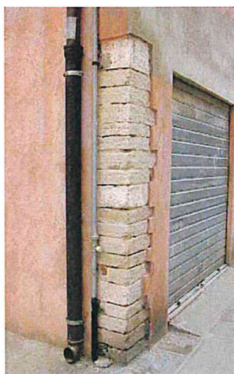
Finestra con i conci predisposti per il fissaggio degli infissi esterni lasciati a vista (in origine ricoperti da intonaco).
