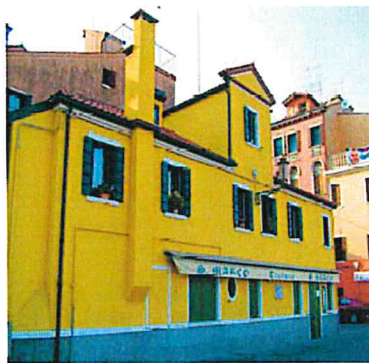
Chioggia e Sottomarina – Recenti intonaci colorati in pasta in varie tonalità di colore.
