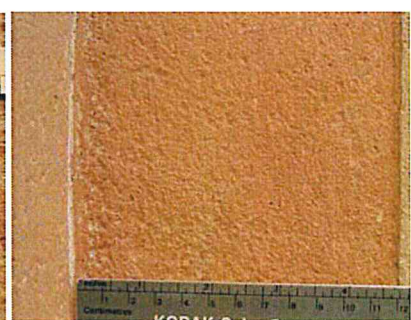
Strato di finitura a base di calce e cotto macinato in polvere.
