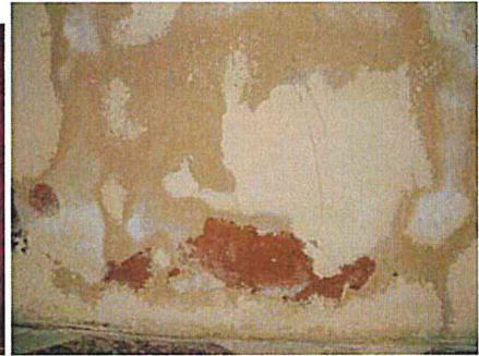
Chioggia – Chiesa di S.Andrea. Particolari della zona basamentale interna corrispondente a quella esterna (segnalata nelle immagini precedenti), dove è stato applicato un intonaco risanante a base cementizia. All'interno, invece, è stato applicato un intonaco da risanamento a base di coccopesto.
