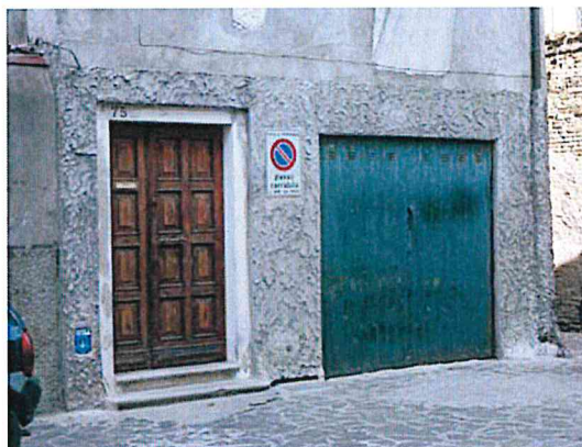
Sottomarina - Particolare di un piano terra rivestito con intonaco cementizio e da uno strato ulteriore di malta cementizia applicata a cazzuola.
