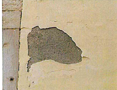
Particolare del degrado della finitura a "marmorino".
