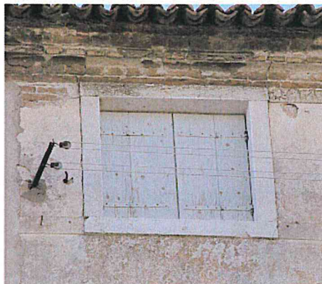
La finestra quadrata dell'attico, con la cornice in pietra d'Istria
