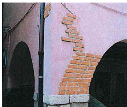
Finti mattoni applicati dopo la stesura dell'intonaco.
