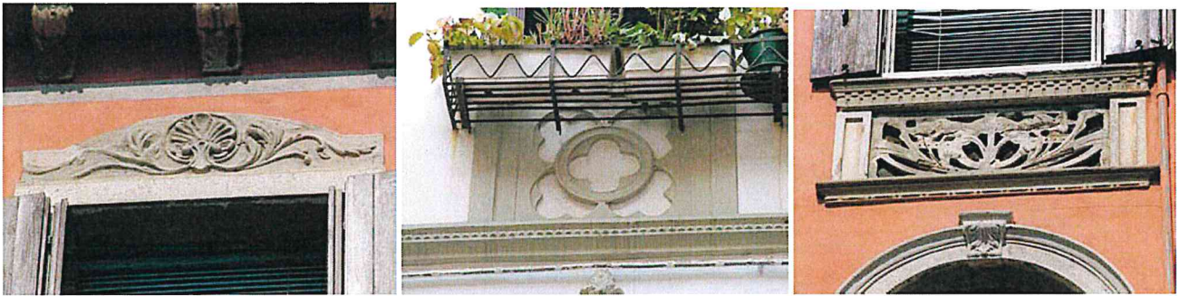
Chioggia – Elementi decorativi tipicamente liberty a motivi floreali realizzati in "pietra artificiale".
