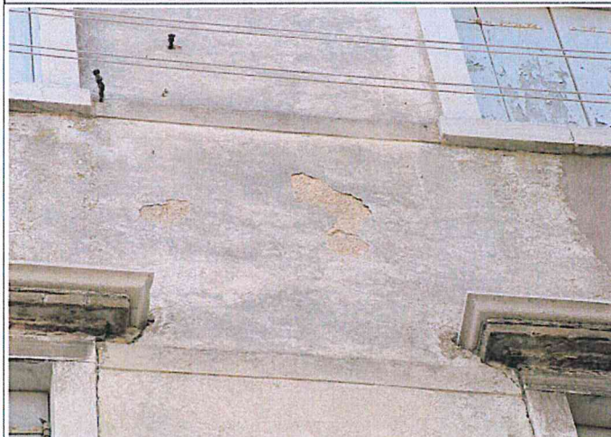
Vista d'insieme dell'intonaco in cocciopesto con la finitura in marmorino, che va in rilievo nelle fasce marcapiano
