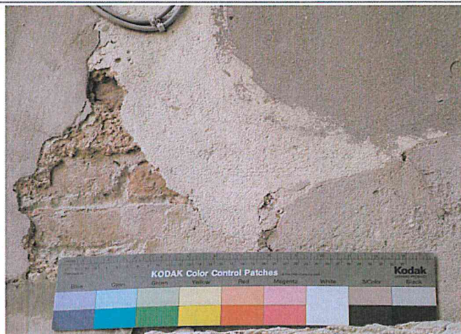
Dettaglio della finitura in marmorino
