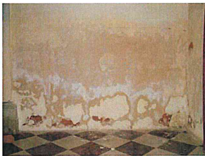
Chioggia – Chiesa di S.Andrea. Particolari della zona basamentale interna corrispondente a quella esterna (segnalata nelle immagini precedenti), dove è stato applicato un intonaco risanante a base cementizia. All'interno, invece, è stato applicato un intonaco da risanamento a base di coccopesto.
