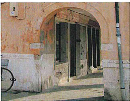
Chioggia – Edificio con intonaco cementizio e finitura moderna di cocciopesto.
