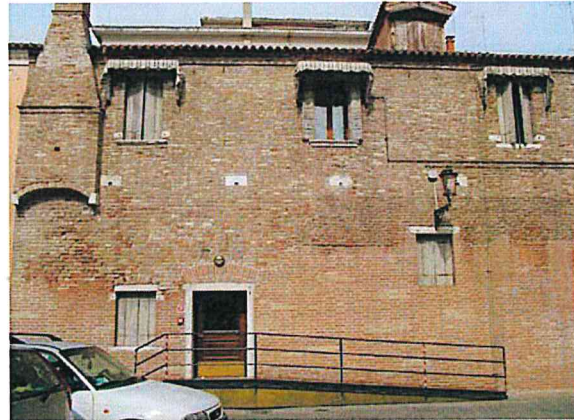
Particolare della facciata dove è evidente la grande porzione di muratura sostituita con il metodo del "cuci scuci".
