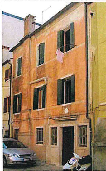
Chioggia - Facciate con intonaci di cocciopesto e finitura di cotto macinato in polvere.
