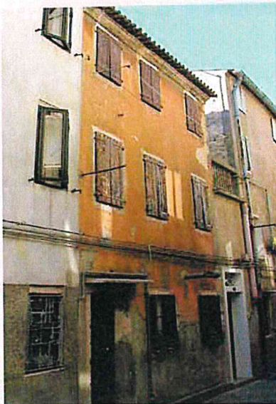
Chioggia - Facciate con intonaci di cocciopesto e finitura di cotto macinato in polvere.
