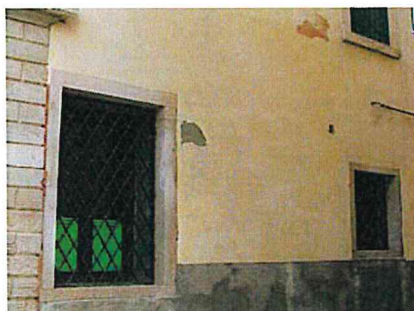
Chioggia – Edificio con intonaco cementizio e finitura a "marmorino".
