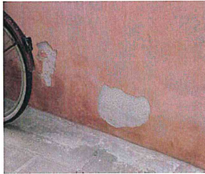
Chioggia- Edificio in Canal Vena. Particolare del distacco della finitura dall' intonaco deumidificante macroporoso
