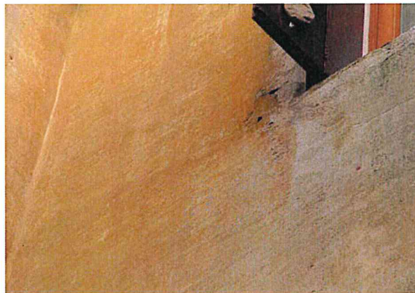
Chioggia – Tinta a calce di colore giallo.
