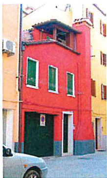
Chioggia e Sottomarina – Recenti intonaci colorati in pasta in varie tonalità di colore.
