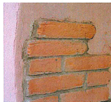
Particolare dei finti mattoni applicati con malta cementizia.
