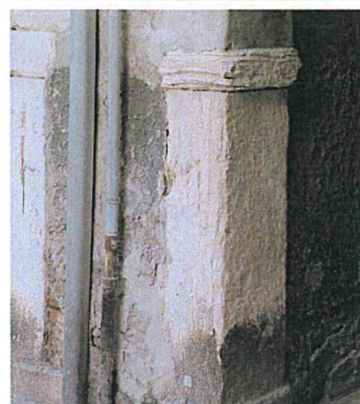
Dettaglio del piedritto in pietra a sostegno dell'arco
