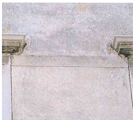
Dettaglio delle fasce marcapiano in marmorino a rilievo
