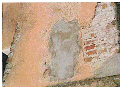
Rappezzo di malta cementizia realizzato su una facciata con finitura a cocchio macinato.
