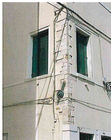
Pietre d'angolo lasciate a vista a diverse altezze e con varie modalità. I cantonali degli edifici erano lasciati a vista, in realtà, solo in alcuni casi, e in tale evenienza i conci erano lavorati con la martellina a denti fitti e rifiniti con lo scalpello, cosa che non accade nei casi qui proposti.
