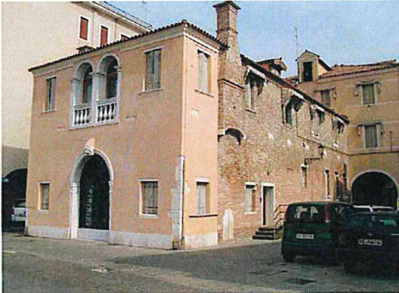
Chioggia – Edificio privato dell'intonaco lungo i prospetti laterali.
