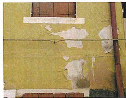
Chioggia e Sottomarina –Tinteggiature di circa 1mm di spessore lavorate in superficie con il frattazzo dentato al fine di ottenere caratteristico effetto "graffiato". Questa finitura è stata utilizzata soprattutto negli anni '80.
