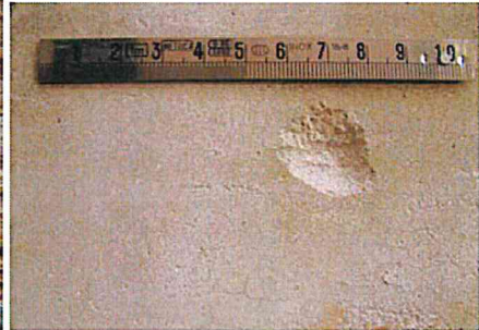
Strato di finitura realizzato con calce e polvere di pietra calcarea, il "marmorino".
