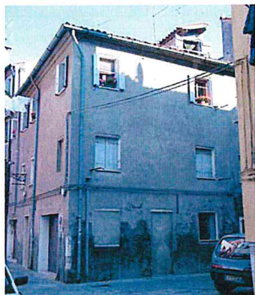
Sottomarina – Edificio con intonaco cementizio. Al piano terra è stato applicato a cazzuola un ulteriore strato di malta di cemento.
