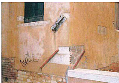
Pietre d'angolo lasciate a vista a diverse altezze e con varie modalità. I cantonali degli edifici erano lasciati a vista, in realtà, solo in alcuni casi, e in tale evenienza i conci erano lavorati con la martellina a denti fitti e rifiniti con lo scalpello, cosa che non accade nei casi qui proposti.
