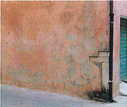
Chioggia – Edificio con intonaco cementizio e finitura moderna di cocciopesto.
