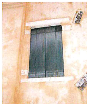
Finestra con i conci predisposti per il fissaggio degli infissi esterni lasciati a vista (in origine ricoperti da intonaco).
