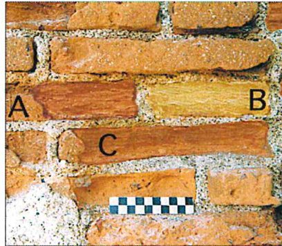
Prove di integrazione con impasti di diverso colore di mattoni
