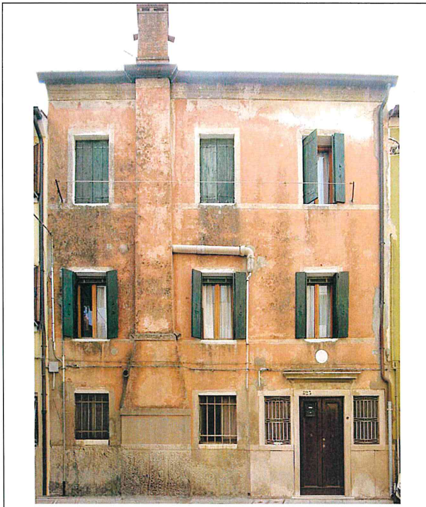
Prospetto – Foto generale di inquadramento dell'intero fronte
