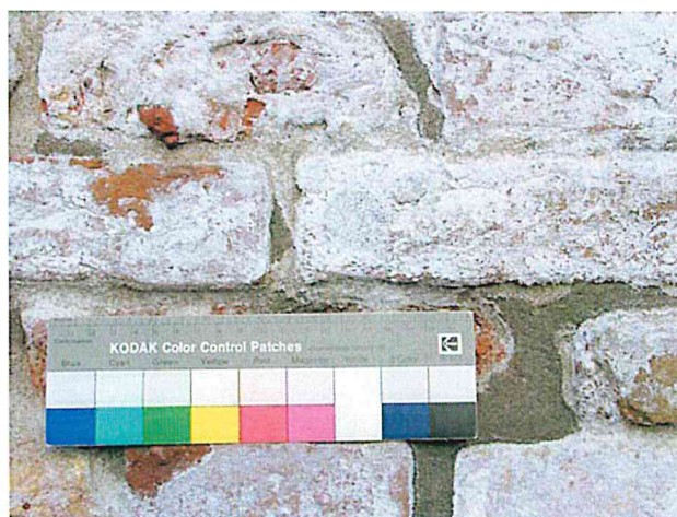
Chioggia- Muratura in mattoni con diffuse efflorescenze saline. In casi di questo tipo l'impacco deve essere applicato dopo aver spazzolato la superficie.
