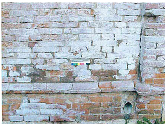
Chioggia- Muratura in mattoni con diffuse efflorescenze saline. In casi di questo tipo l'impacco deve essere applicato dopo aver spazzolato la superficie.
