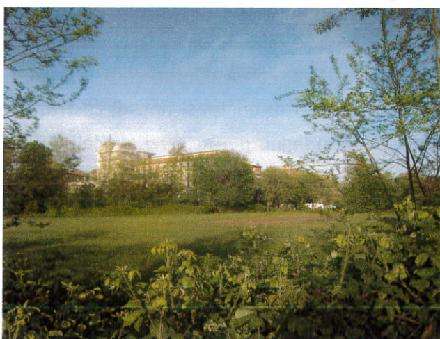
Foto 13 Il lato est confinante con edifici alti e parcheggio
