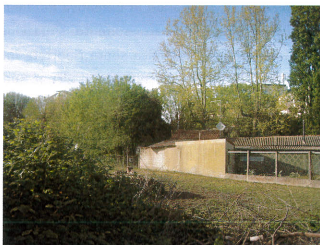
Foto 14 Recinzione fra area d'intervento e zona edificata
