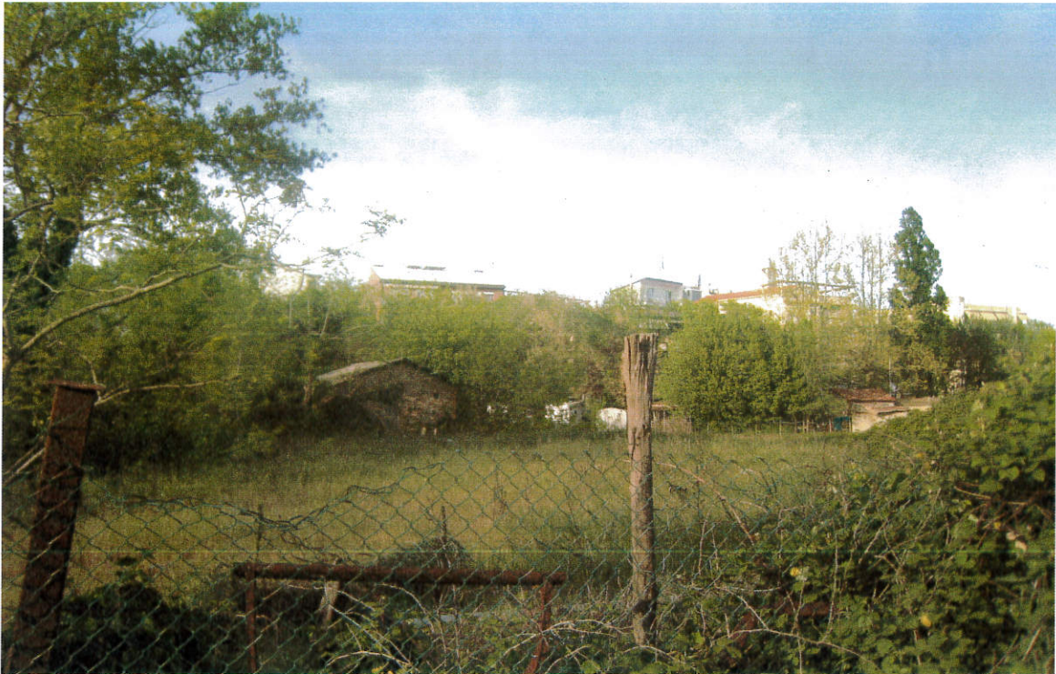
Foto 10 Vista d'insieme ripresa da sud-est dell'Area d'intervento Ex Batteria Forte Penzo-Ambito n°2, suddivisione Lotto est. Si evidenzia la presenza di un piccolo manufatto precario agricolo destinato alla demolizione. A destra nella foto, oltre il confine di proprietà, si intravedono le roulotte e i campers del parcheggio privato non facente parte dell'ambito in questione. Sullo sfondo i caseggiati di Viale Bergamo.
