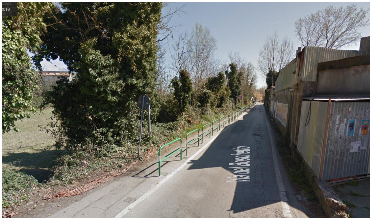
15_ Via del Boschetto con vista da ovest verso est
