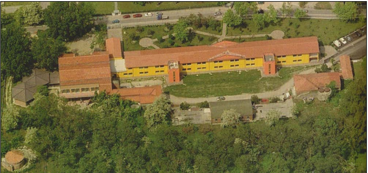
Fig. 27 - Vista dall'alto della Batterie Penzo (2008).
