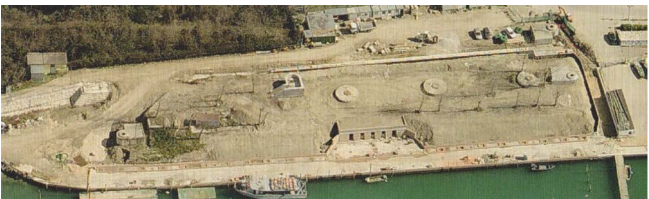
Fig. 30 - Foto aerea della Batteria Sottomarina durante i lavori di restauro dell'opera (2004-2005).
