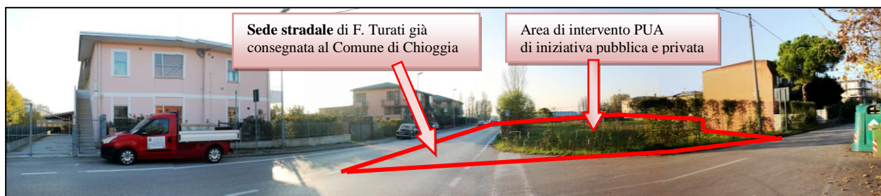
Foto n.03 Vista da via Filippo Turati angolo via Riccardo Lombardi
