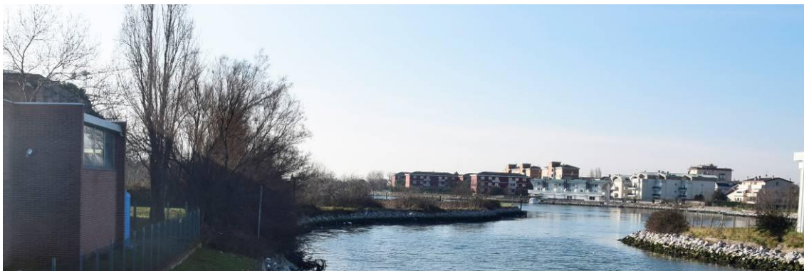
Figura 6 - Panoramica area a sud lungo Lusenzo verso l'Ospedale (ponte di legno)
