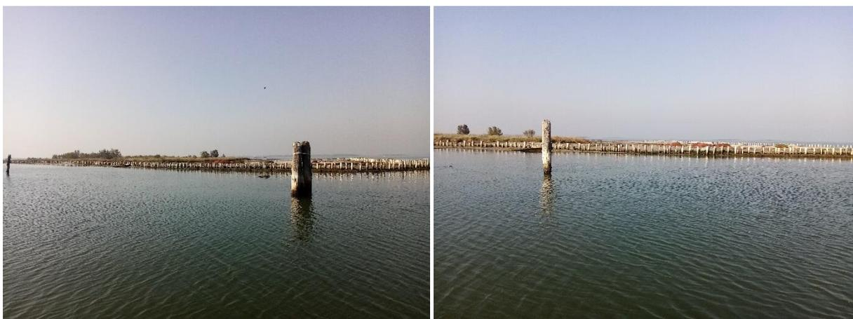
**Figura 73: tratti di palificazione a protezione delle sponde delle barene presenti lungo il canale Novissimo o dell'Otregano nell'area di analisi**
