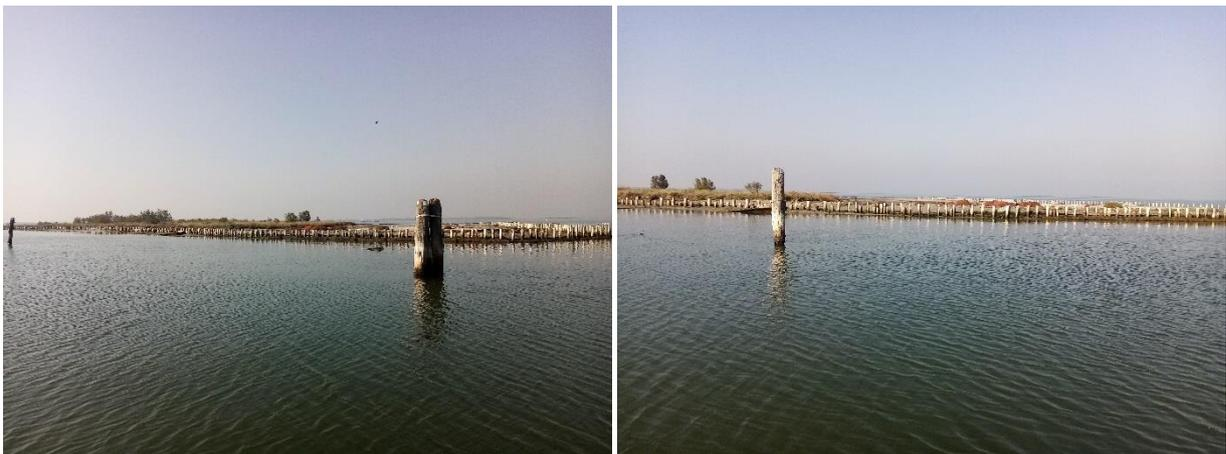
**Figura 93: tratti di palificazione a protezione delle sponde delle barene presenti lungo il canale Novissimo o dell'Otregano nell'area di analisi**
