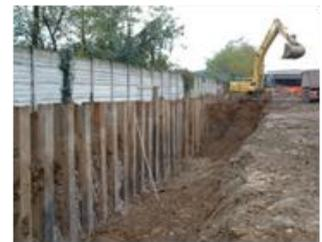
Figura 6: esempio di palancole utilizzato per delimitare gli specchi d'acqua
