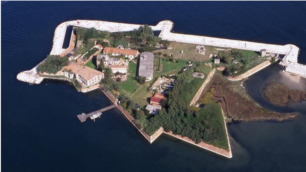
Ripresa aerea del Forte S. FELICE
